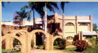
1992 Centre Visiteurs, Auroville
