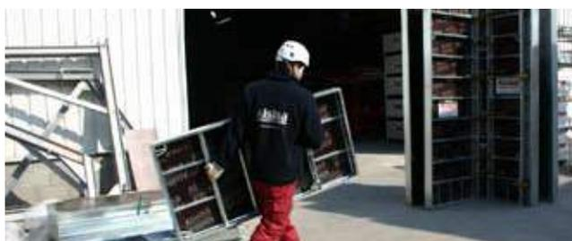
Le système Alisply Manual est vraiment léger avec seulement 30 kg/m<sup>2</sup>, ce qui en fait un système idéal à utiliser sur les chantiers ne disposant pas de grue. À l'opposé, la haute gamme d'accessoires du système permet le montage de grands écrans, afin de le manipuler et de le positionner avec une grue.
