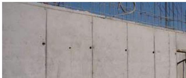
Le système Alisply Manual est fabriqué avec une structure en acier zingué pour le protéger de la corrosion. La surface de coffrage est un tablier en contreplaqué phénolique de 12 mm d'épaisseur, protégé par de la mélamine de 240 gr/m<sup>2</sup> qui offre une finition de béton apparent.
