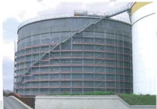
Entretien d'une cuve de produits pétroliers
