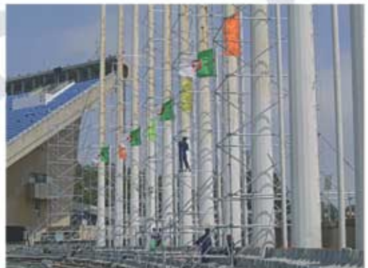
Structure de spectacle stade du 05 juillet . Alger
