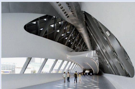
Pavillon PONT EXPO Saragosse, Espagne par ZAHA HADID
